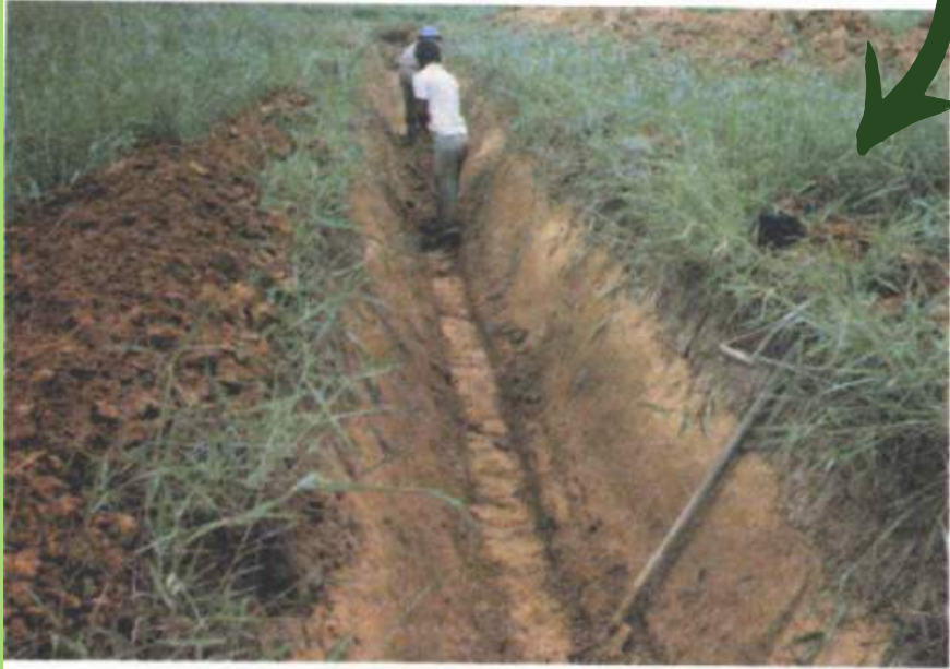
FOTOGRAFIA ESCAVAÇÃO DE VALETA
