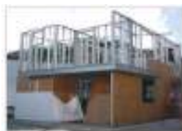
Figura 44: Vedação com Placas OSB e MCMV – Paraná (Fonte: Siding)
