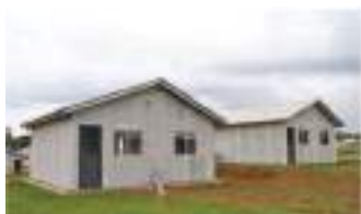
Figura 42: Vedação com Placas Cimentícias – MCMV – Paraná (Fonte: Saint Gobain)
