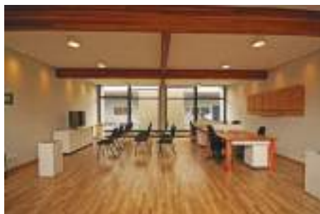
Figura 95: Uso de MLC aparente no Núcleo Senai de Sustentabilidade, Curitiba/Paraná
