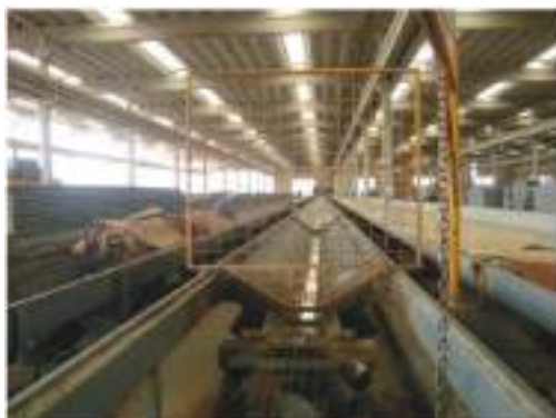
Figura 79: Fábrica de estruturas pré-fabricadas de concreto, com cobertura em telhas W com domos, em produção das telhas W (pistas)
