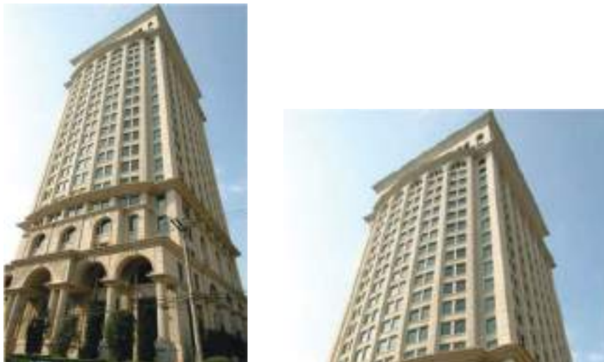
Figura 77: Edifício San Paolo – São Paulo (SP): (a) Fachada com elementos e painéis pré-fabricados arquitetônicos; (b) Elemento arquitetônico pré-fabricado que compõe o arco na entrada
