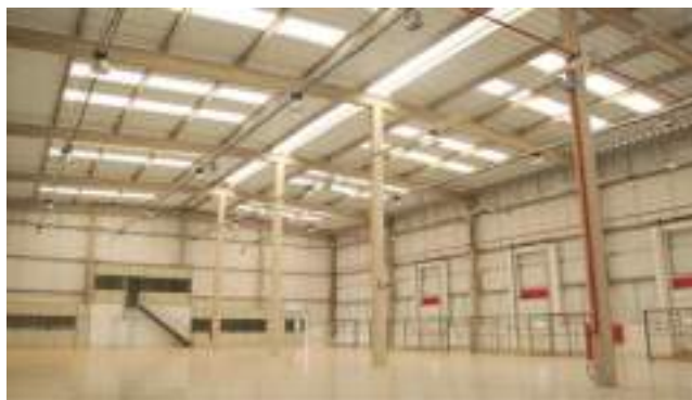
Figura 80: Cobertura com telhas metálicas para vãos menores
