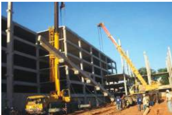
Figura 83: Situações transitórias – içamento de pilares pré-fabricados durante a montagem
