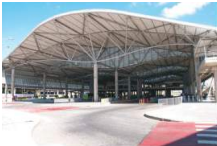
Figura 87: Terminal rodoviário urbano de integração do BRT de Belo Horizonte, em estrutura híbrida, pilares pré-fabricados de concreto e cobertura metálica
