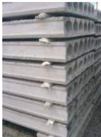
Figura 82: Situações transitórias: armazenamento de lajes alveolares pré-fabricadas
