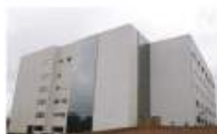
Figura 47: Fachada em light steel framing com vedação em Placas Cimentícias (Fonte: Saint-Gobain)
