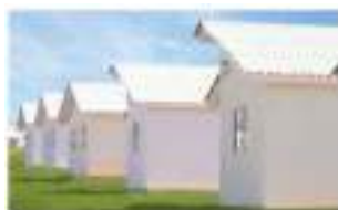
Figura 43: Vedação com Placas Cimentícias – MCMV – Paraná (Fonte: Saint-Gobain)
