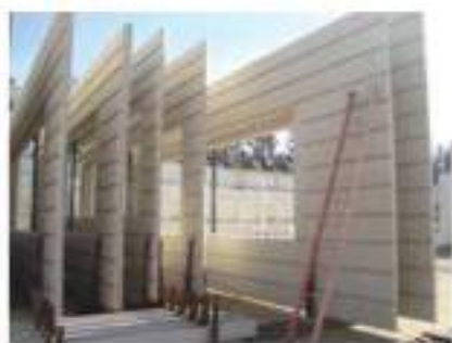
Figura 1: Painéis de vedação pré-fabricados de concreto (Fonte: ABCIC)
