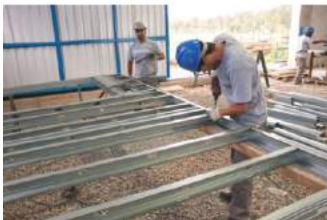
Figura 50: Sistema de painéis (Fonte: Construtora Micura)
