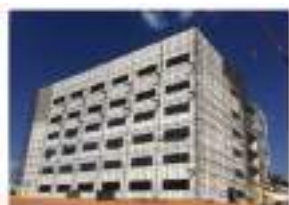
Figura 46: Fachada em light steel framing com vedação em Placas Cimentícias (Fonte: Saint-Gobain)
