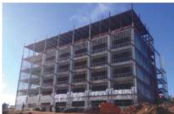
Figura 41: Edifício Educacional multi-pavimentos. Fachada em light steel framing (Fonte: Saint-Gobain)
