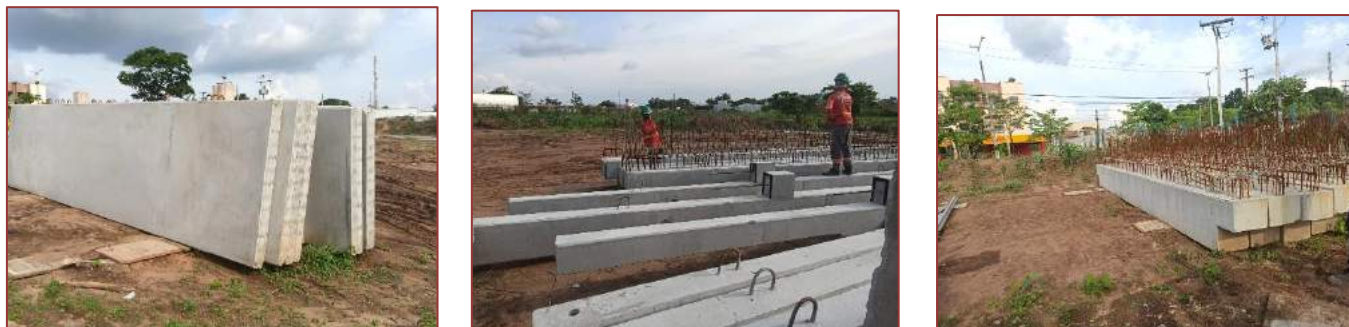
Figura 6, 7 e 8 – Peças pré-moldadas (painel, pilar e viga, respectivamente)
