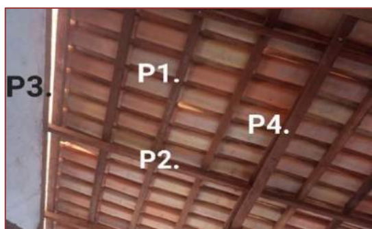
Figura 2- telhado com madeira Taxi.
