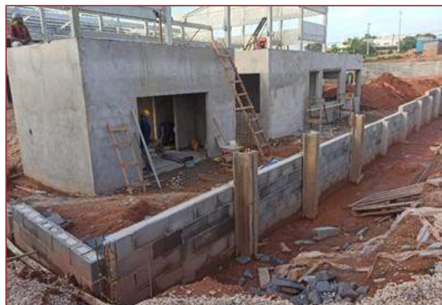
Figura 1 - Muro de Arrimo
