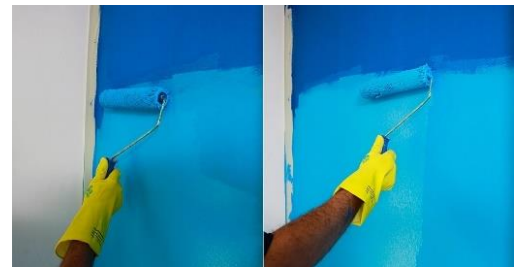
Figura 82- Demão de azul claro sendo aplicada a uma demão anterior de azul escuro
