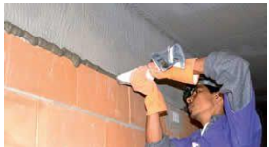
Figura 14- Execução do aperto entre alvenaria e viga
