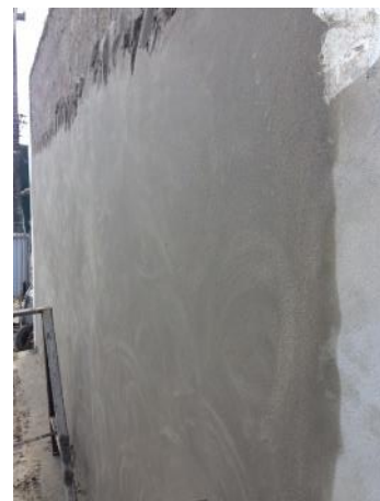
Figura 85- Parede desempolada
