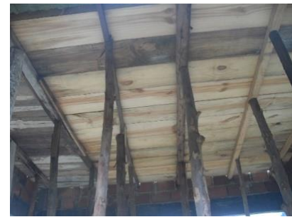
Figura 194- Assoalho de laje, "Taipá"
