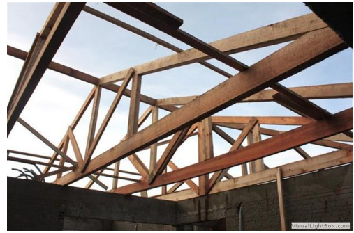
Figura 199- Tesouras de telhado
