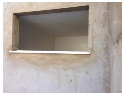
Figura 163- Peitoril em janela alta
