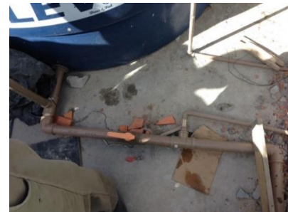
Figura 35- Barrilete de pequena extensão
