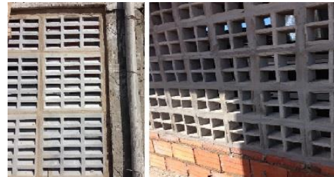
Figura 70- Cobogó tipo escama e cobogó de abertura quadrada, ambos de cimento
