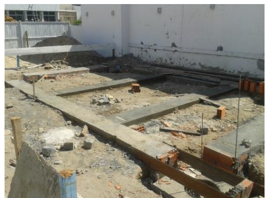
Figura 72- Concreto magro dado para a confecção de vigas baldrames.
