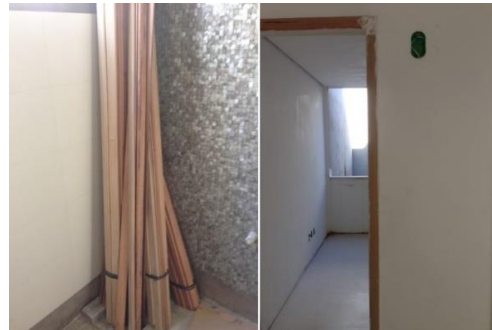
Figura 10- Alisares a serem assentados e alisares já assentados na aduela
