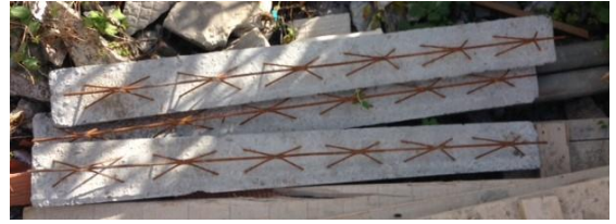
Figura 207- Vigotas para laje pré moldada
