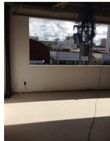
Figura 156- Parapeito em vão de janela
