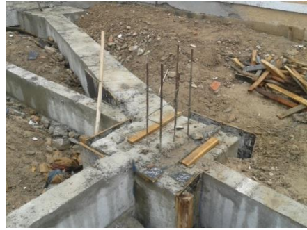
Figura 19- Arranque de pilar armado em bloco de fundação.
