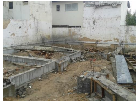
Figura 30- Vigas baldrames concretadas
