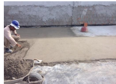
Figura 75- Execução de contrapiso
