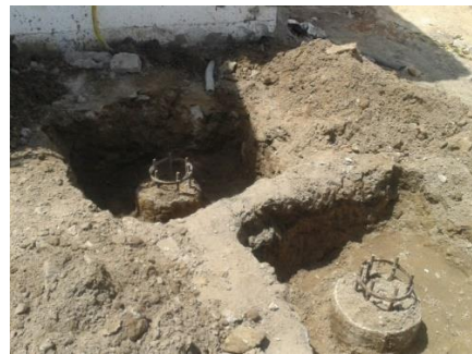
Figura 20- Cabeças de estacas arrasadas até a cota de arrasamento
