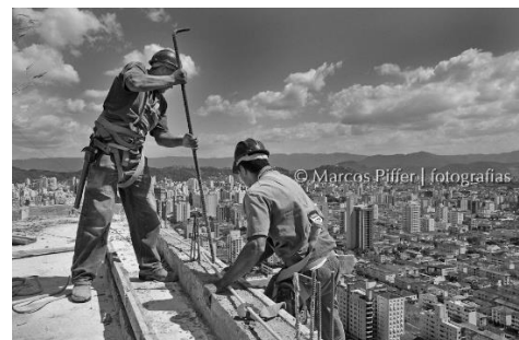
Figura 86- Desforma de viga
