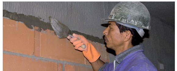
Figura 21 - Arremate de assentamento de blocos com encunhamento
