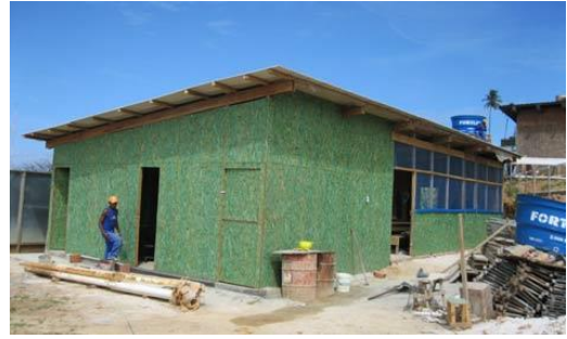
Figura 34- Barracão de madeira
