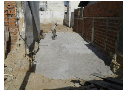
Figura 24- Espalhamento de aterro
