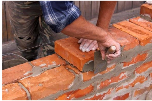
Figura 22- Tijolo sendo assentado
