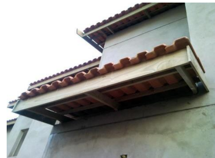
Figura 193 - Tabeiras em telhado
