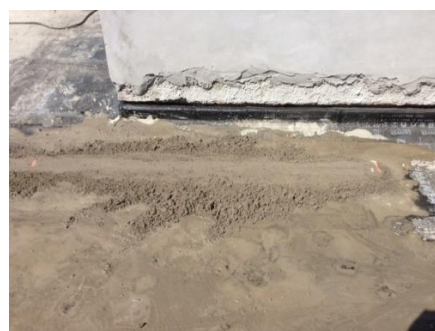
Figura 146- Mestra feita para a execução de contrapiso
