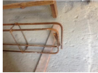
Figura 13- Extremidade de armação de viga com ancoragem
