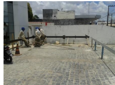
Figura 110- Gabarito implantado
