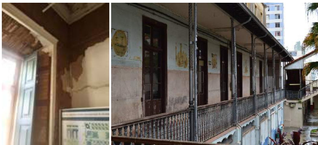
Figura 8: À esquerda, sobrado do Barão de Itatiba: detalhe construtivo de uma das paredes construída em taipa de pilão que encontra outra parede construída com a mesma técnica e encamisada com tijolos. À direita, residência do Barão de Itapura. Detalhe do alpendre junto ao jardim interno. Destaque para as abobadilhas de alvenaria de tijolos com vigas metálicas e para os elementos de ferro como gradis e colunelas. Fonte: Thaina Isabela Silva e Leonardo Rosa.
