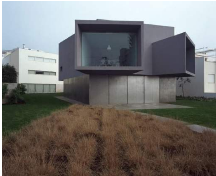
Imagem 02: Fachada principal da Casa do Cinema Manoel de Oliveira –
