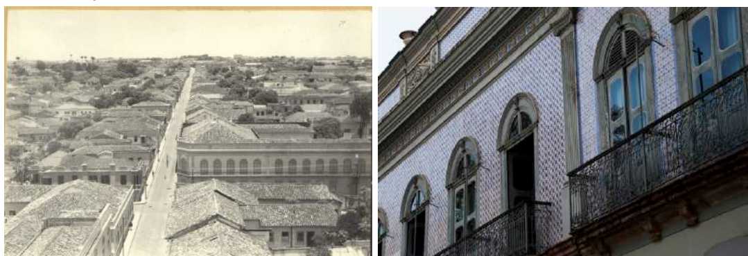
Figura 3: À esquerda, o sobrado do Barão de Itatiba destacando a implantação na esquina e o alinhamento da construção aos limites do lote urbano. À direita, detalhe do revestimento da
