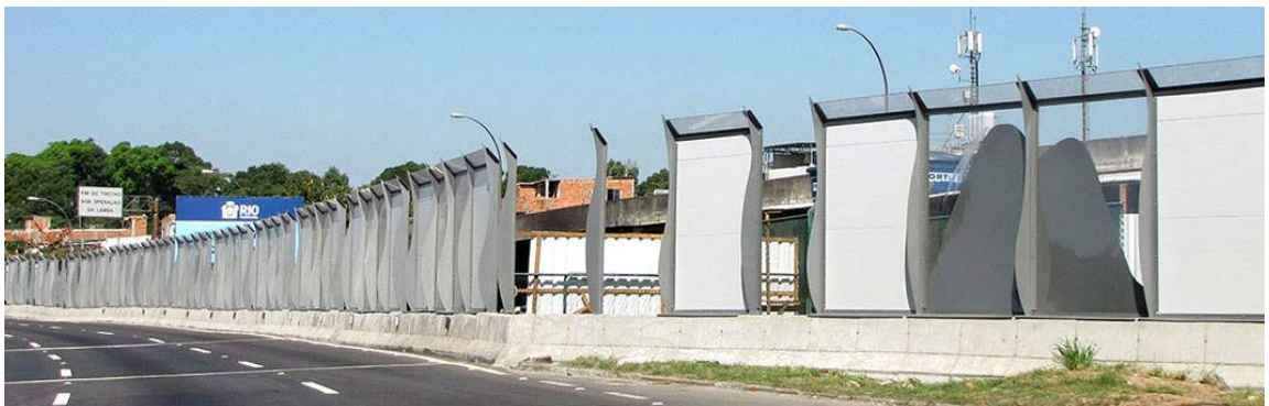
Figura 1 - A “Barreira Acústica” sendo instalada na Linha Vermelha
