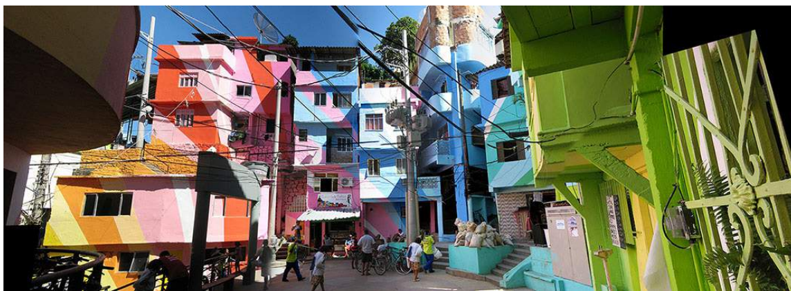
Figura 3 - A Praça do Cantão, após intervenção de pintura
