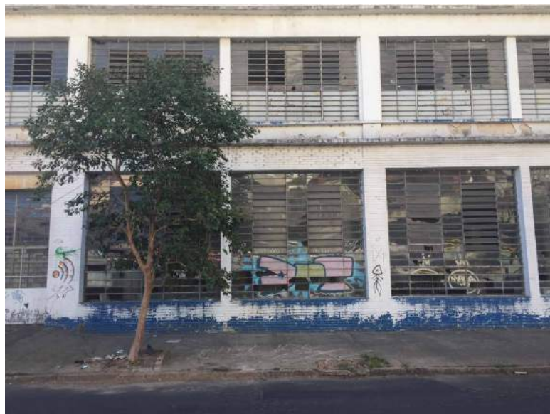
Figura 10: Prédio com as janelas quebradas na mesma rua do complexo Vila Flores.
