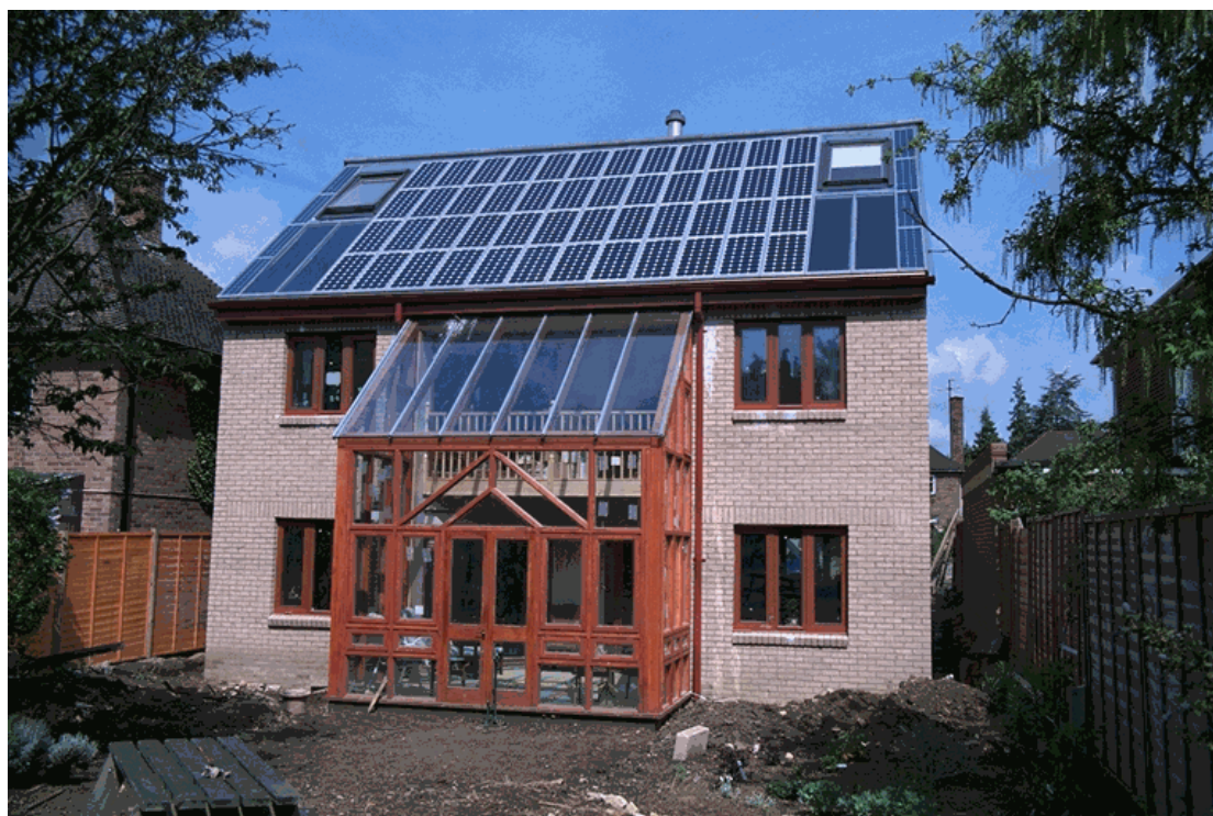
Figura 31: Exemplo de uma instalação de painéis fotovoltaicos [40]
