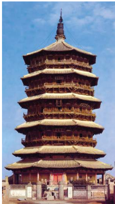
FIGURA 1: Pagode no condado de Ying, ao norte da província de Shanxi, 1056: a mais antiga e mais alta torre inteiramente construída em madeira do mundo (SHANGAI DAILY, 2018).
